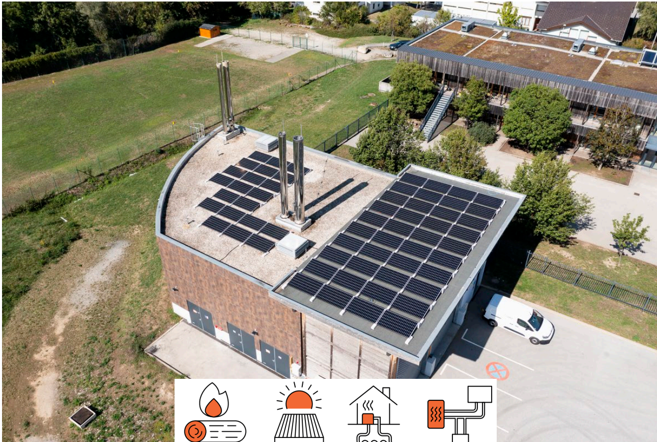
Exemple de chaufferie bois à Reignier-Esery - © Gilles Bertrand
