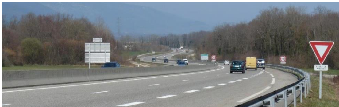
Le GBA ajoute un obstacle sur la 2x2 voies et augmente la mortalité de la faune – on notera la glissière béton entre les voies, qui entrave fortement le déplacement des animaux
