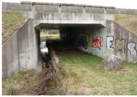
Ouvrage mixte avec banquette semi-végétalisée
