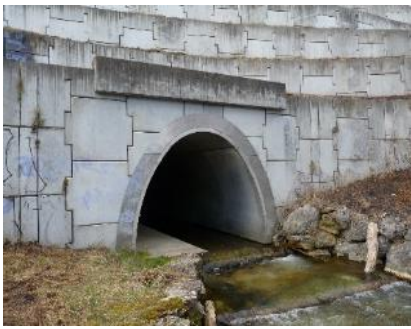
Ouvrage mixte avec banquette goudronnée
