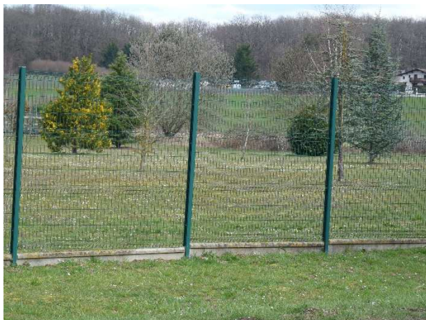
Figure 7 – Exemple de clôture imperméable
