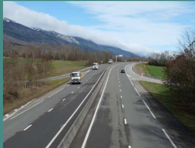
Route à fort trafic et GBA central
