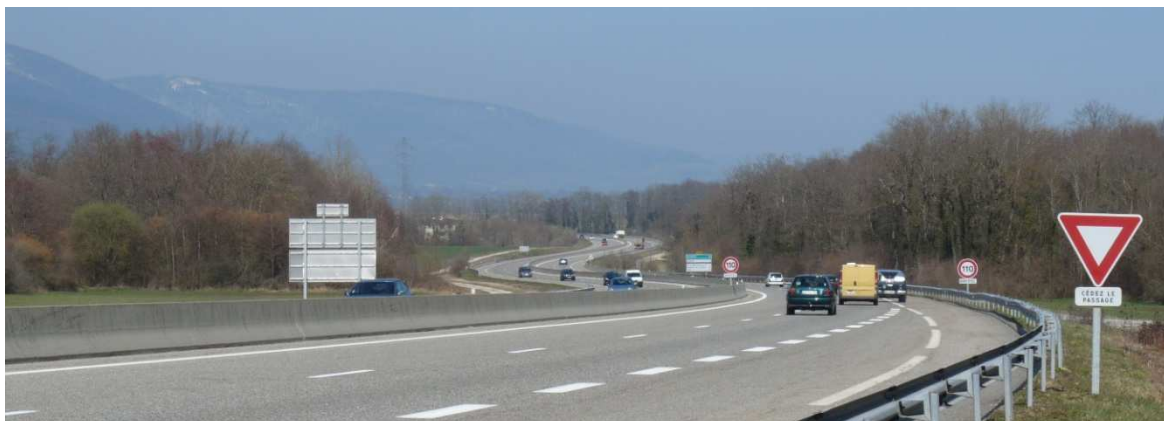
Figure 3 – Le GBA ajoute un obstacle sur la 2x2 voies et augmente la mortalité de la faune– on notera la glissière béton entre les voies, qui entrave fortement le déplacement des animaux
