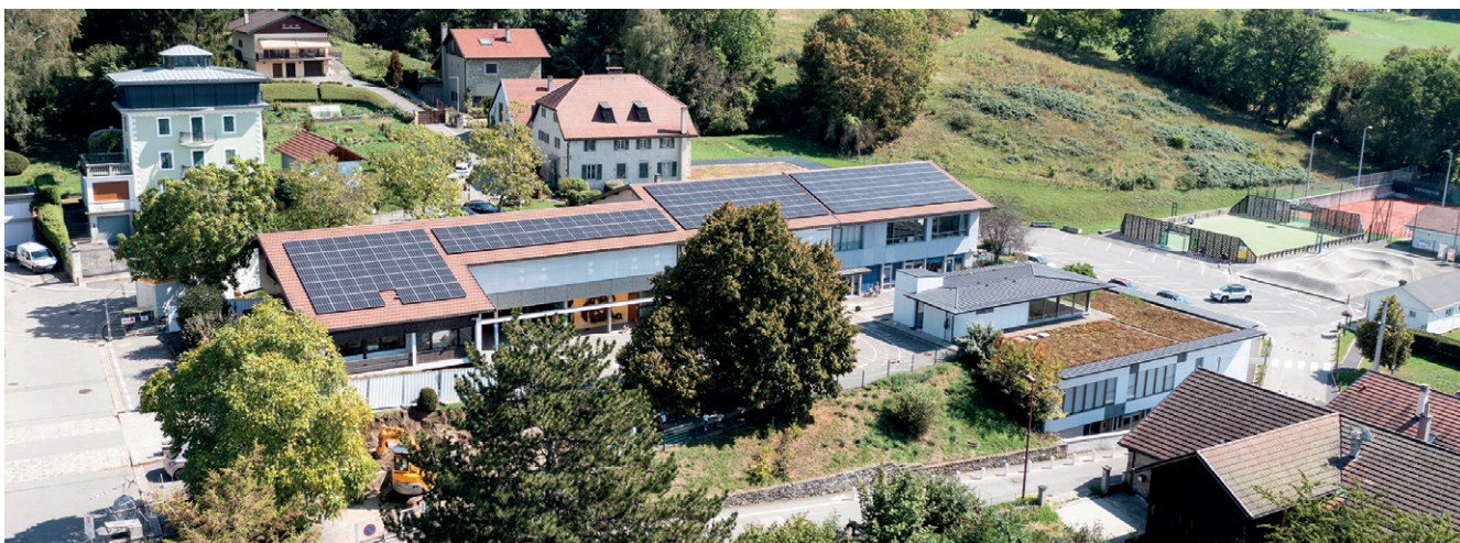
À Lucinges, la production des centrales solaires installées sur l'école et le préau couvre l'ensemble des besoins d'électricité des bâtiments communaux (école, groupe scolaire, mairie...) soit 120 MWh/an.
