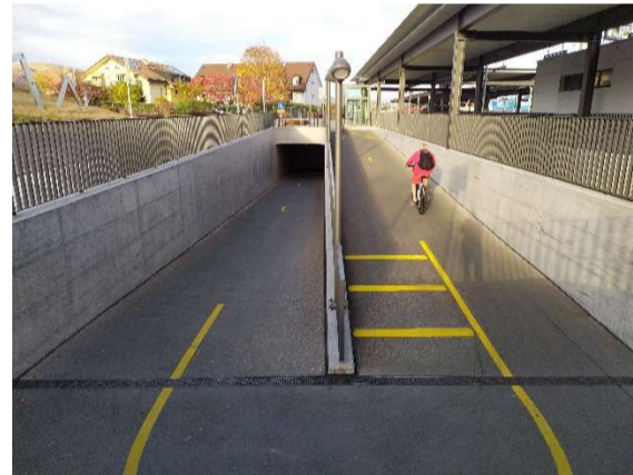
Figure 6 : Passage sous voie à Gland
